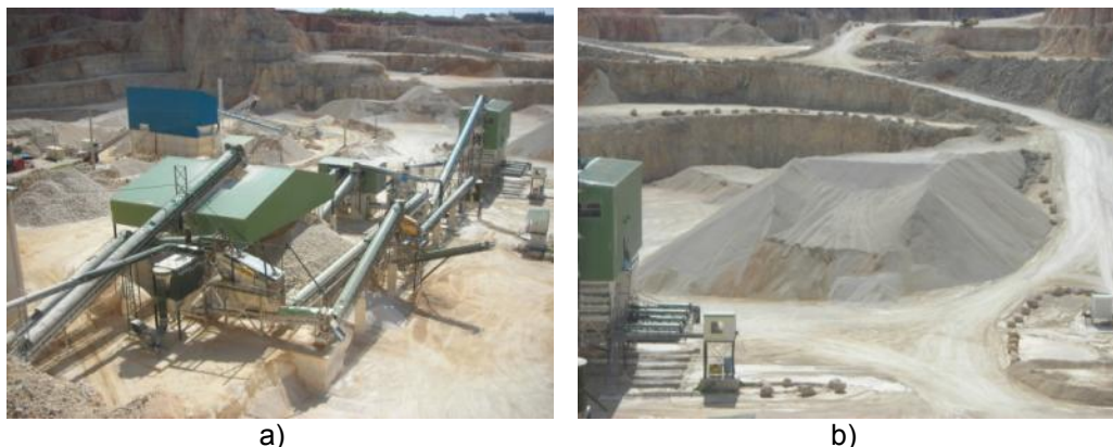
Figura 3.22 a) Central de processamento da Pedreira Vale Grande nº 2; b) armazenamento temporário de calcário após britagem
