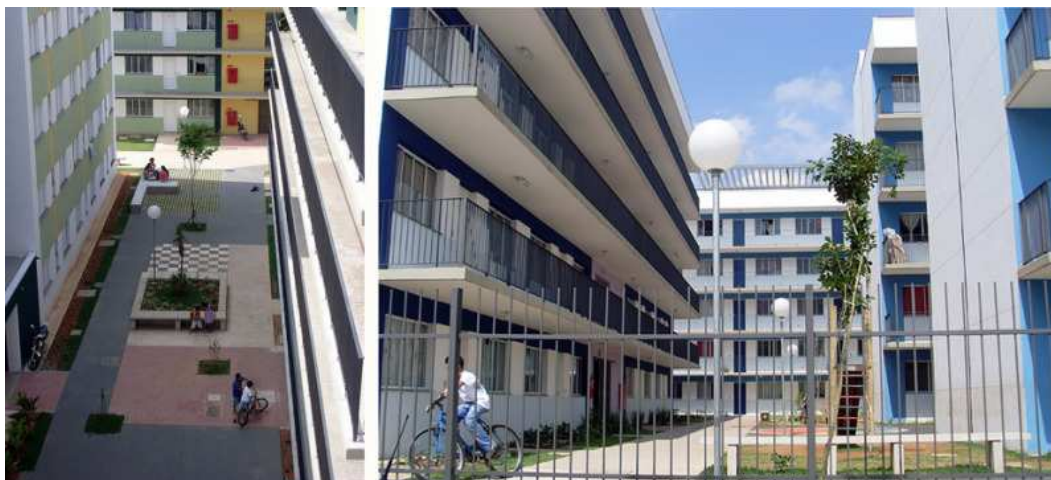
Fig. 03: Residencial Alexandre Mackenzie, para realojamento de parte da favela Nova Jaguaré, Prefeitura da Cidade de São Paulo / Secretaria Municipal de Habitação / Superintendência de Habitação Popular; projecto de Boldarini Arquitetura e Urbanismo - Marcos Boldarini e Sergio Faraulo (autores); paisagismo de Marcos Boldarini, Melissa Matsunaga e Simone Ikeda (autores).
