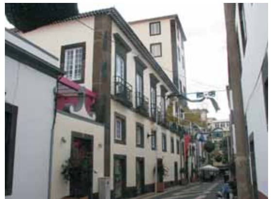
Fig. 5 - Vista exterior do edifício de escritórios (Palácio dos Ornelas).
