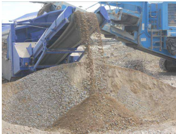
Figura 5.1 | Central móvel de britagem de RCD, no Seixal
