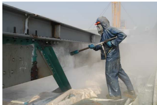
Fig. 3: Exemplo de decapagem por projecção, neste caso, de água. (cedida por REFER)
