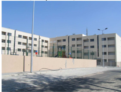
Figura 1 - Vista parcial do empreendimento selecionado.
