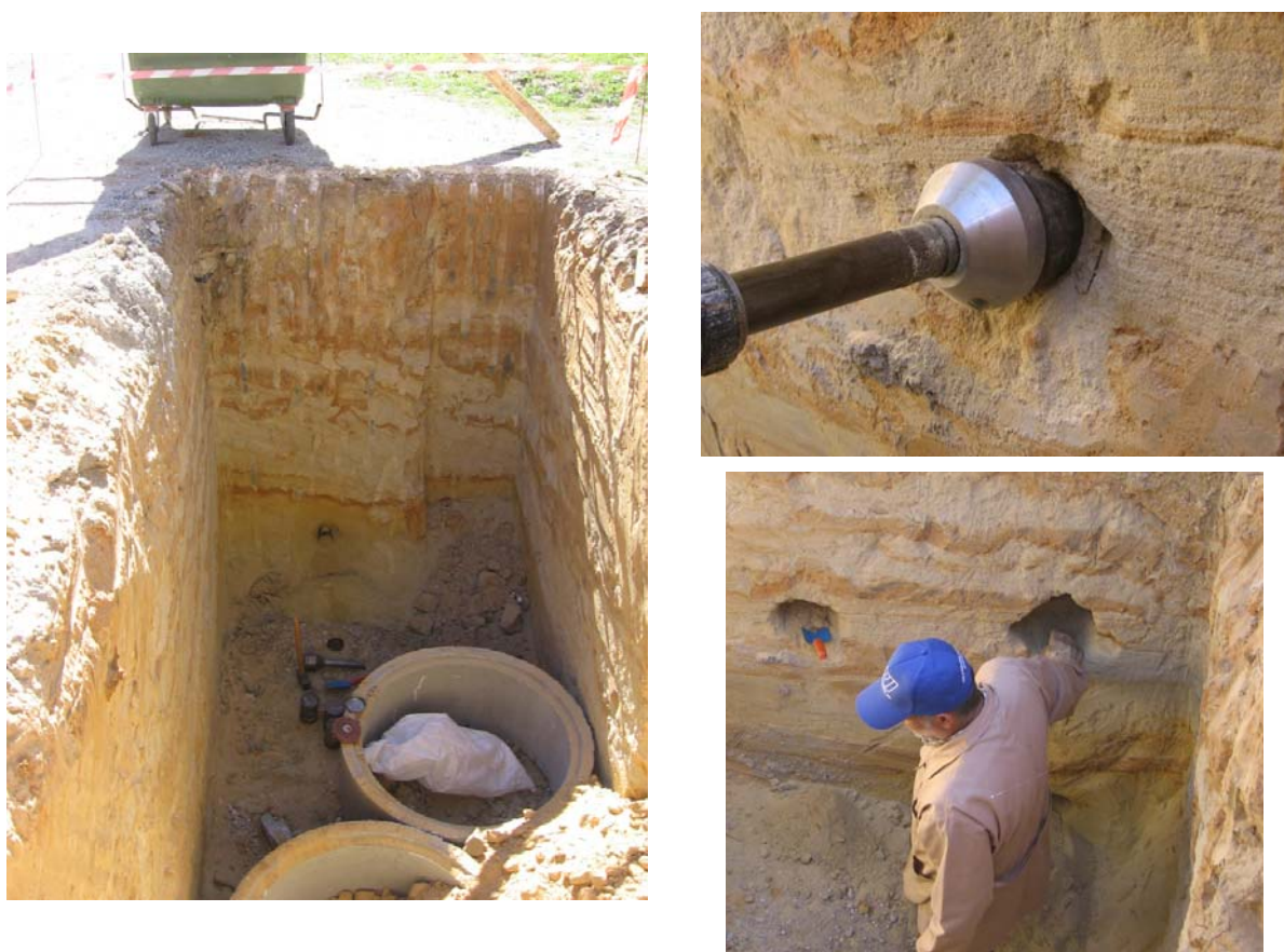
Figura 6.90 – Aspectos da vala aberta no campus do LNEC junto ao pavilhão do Cuama e da recolha de amostras.
