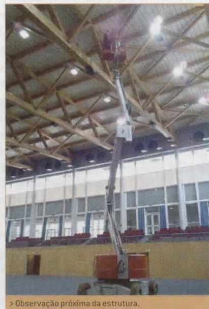
> Observação próxima da estrutura.
