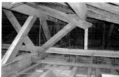
Figura 3 – Alteração da estrutura.
