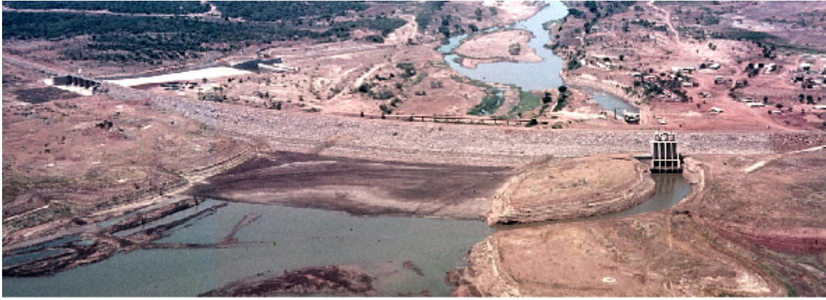
Figura 4 - Vista aérea da barragem de Massingir e do tapete impermeabilizante no final da fase construtiva (Arquivo pessoal de Álvaro Carmo Vaz)
