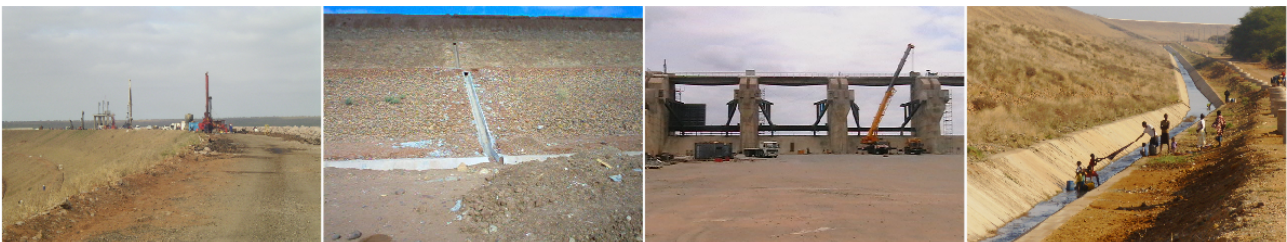
Figura 5 - Trabalhos de reabilitação: injeções, banquetta, comportas e poços de alívio
