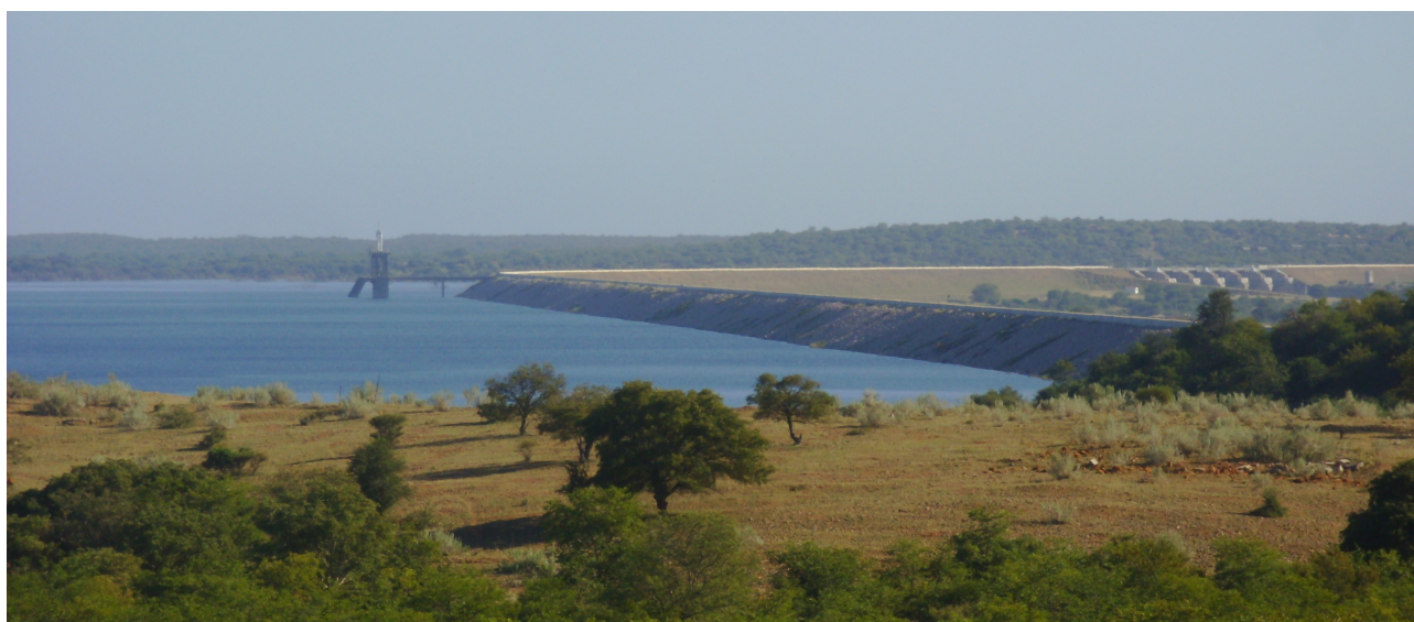
Figura 2 - Vista de montante (e da margem direita) da barragem de Massingir
