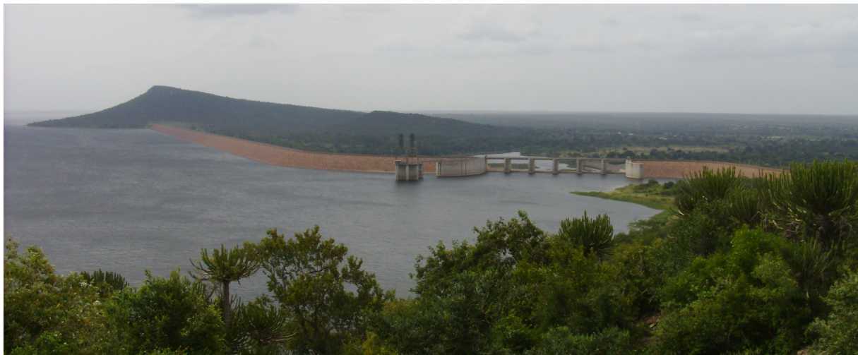
Figura 3 - Vista de montante da barragem da Corumana
