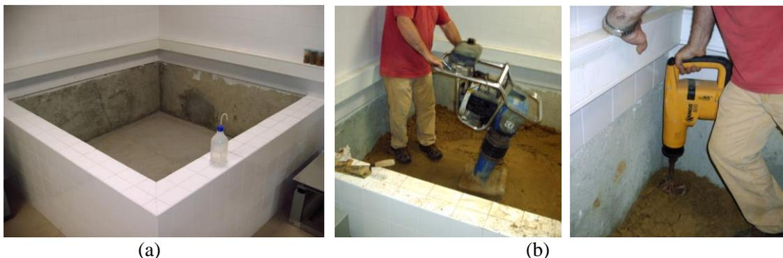
Figura 6 – Tanque: (a) Regularização do fundo com betonilha e (b) compactação da camada de solo fino
