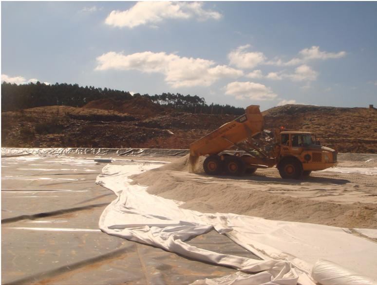
Figura 12 – Colocação da camada de drenagem na base de um aterro
