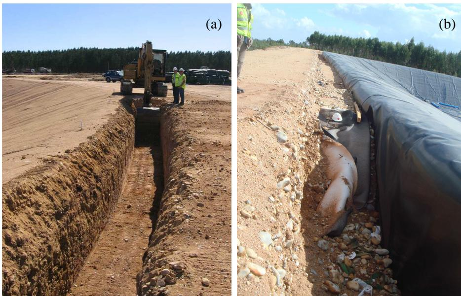
Figura 9 – Vala de ancoragem: (a) abertura; (b) geossintéticos carregados
