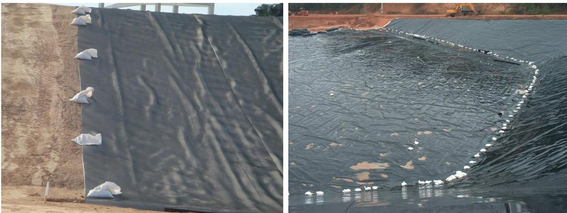
Figura 11 – Exemplo carregamento provisório com sacos de areia
