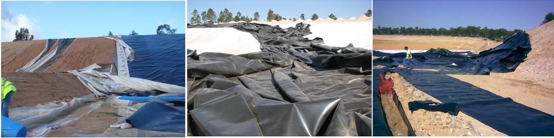
Figura 22 – Exemplos de danos na geomembrana por acção do vento
