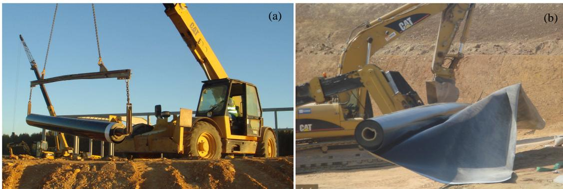
Figura 4 – Exemplo de transporte de geossintéticos: (a) adequado e (b) inadequado
