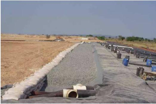
Figura 36 – Geomembrana (*interlift liner*) antes da colocação do minério fresco (Lupo, 2010)
