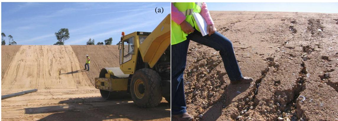
Figura 7 – Superfície de apoio no talude: (a) adequado e (b) inadequado
