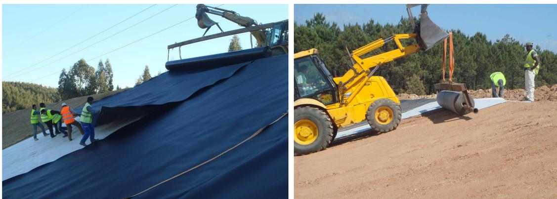
Figura 5 – Exemplos de manuseamento adequado
