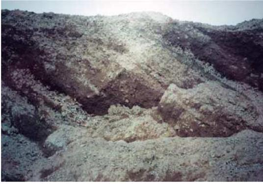
Figura 34 – Rotura do talude devido à segregação do solo e caminhos de preferenciais de solução lixivante (Steemson & Smith, 2009)
