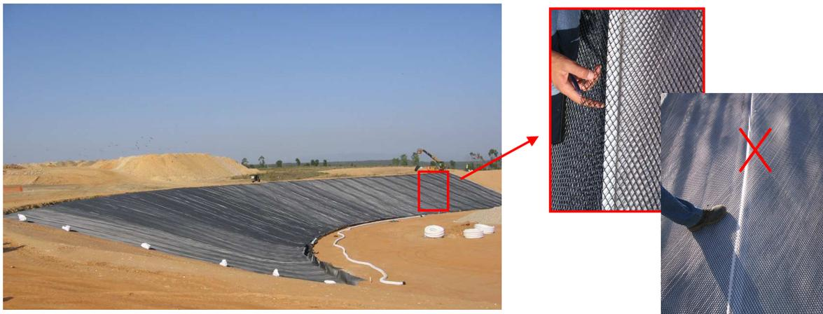
Figura 18 – Exemplo de união de rolos de geocompósito drenante
