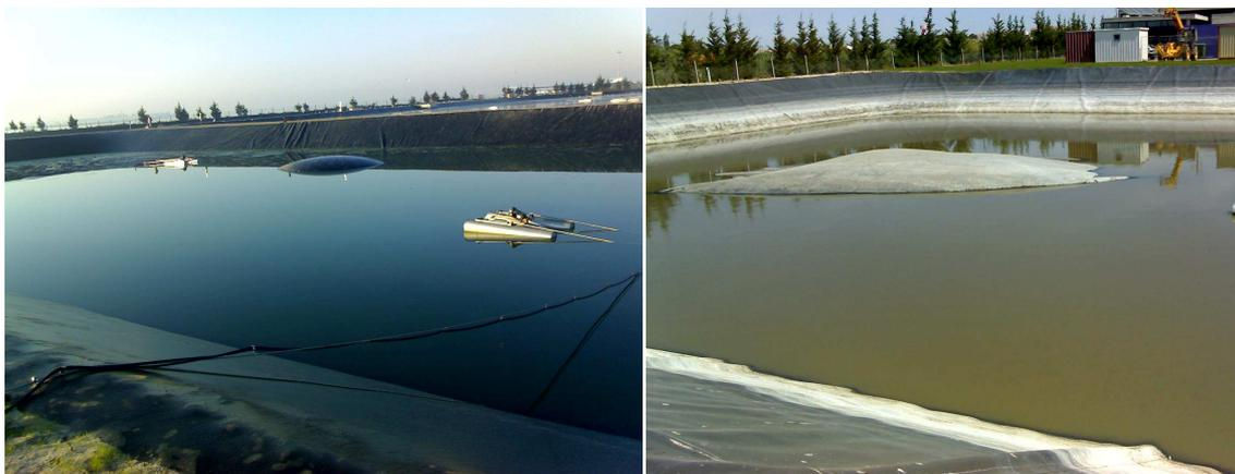
Figura 25 – Exemplo de empolamento em geomembranas
