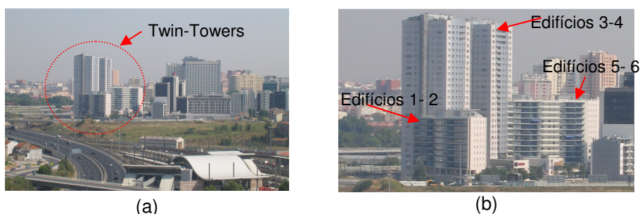
Figura 1 - Complexo de edifícios das Twin-Towers : a) localização e b) edifícios do complexo.
