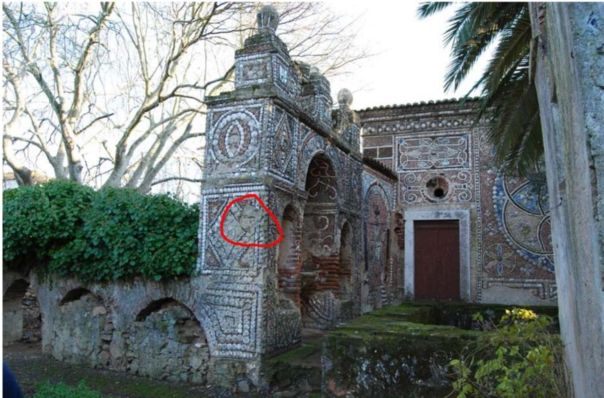
Figura 51 – Imagem do local de extracção do revestimento de embrechados numa parede na zona do horto.
