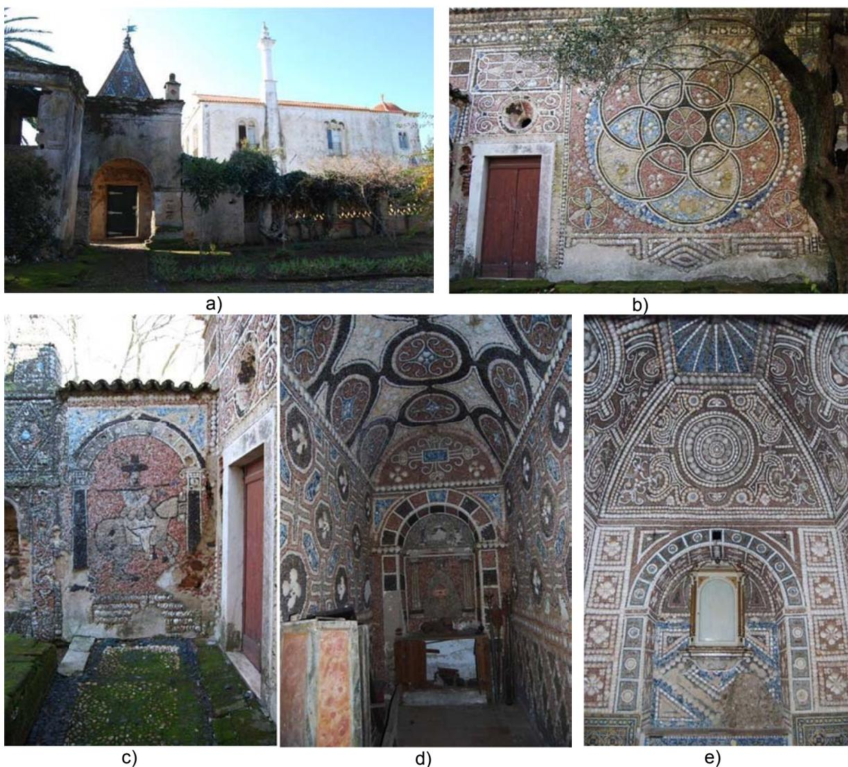
Figura 10 – Vista do Paço das Alcáçovas e da entrada no horto; b,c) Pormenores do revestimento com embrechados das paredes na zona do horto; d,e) Pormenores do revestimento do interior da Ermida de N<sup>a</sup> Sr.<sup>a</sup> da Conceição.
