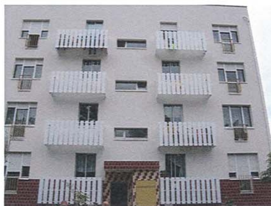
Blocos 21, 22, 25 e 26 (Reabilitados)
