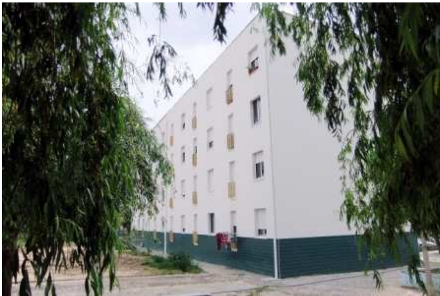
Fig. 19: a obra já concluída em alguns edifícios
