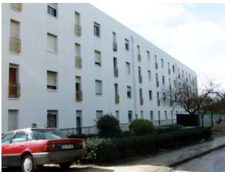
Fig. 13: a obra quase concluída em alguns edifícios
