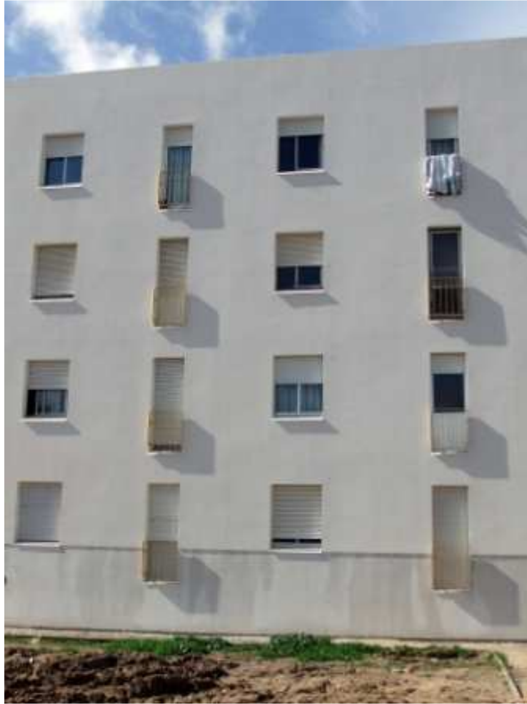
Fig. 14: a obra quase concluída em alguns edifícios
