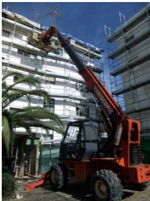
Fig. 09: a aplicação de uma das camadas que integram a solução de isolamento pelo exterior aplicada nos edifícios do Bairro.
