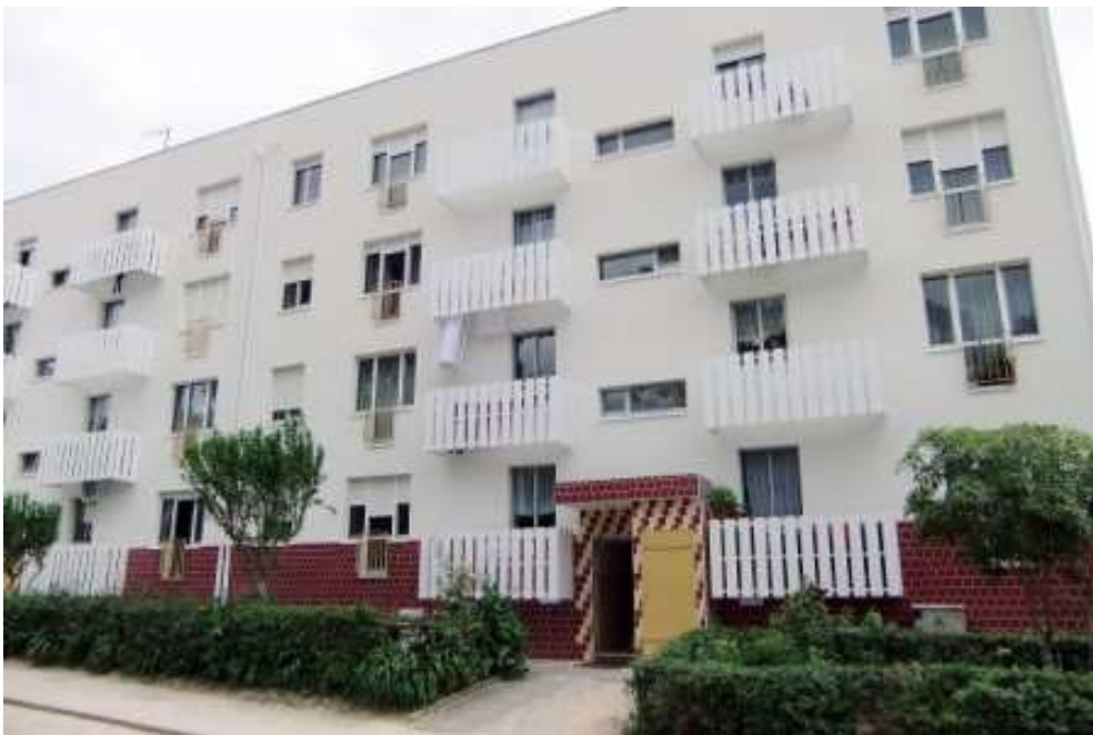
Fig. 15: a obra já concluída em alguns edifícios
