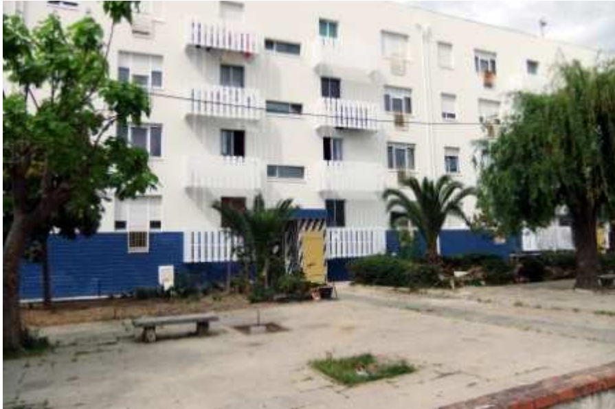
Fig. 18: a obra já concluída em alguns edifícios
