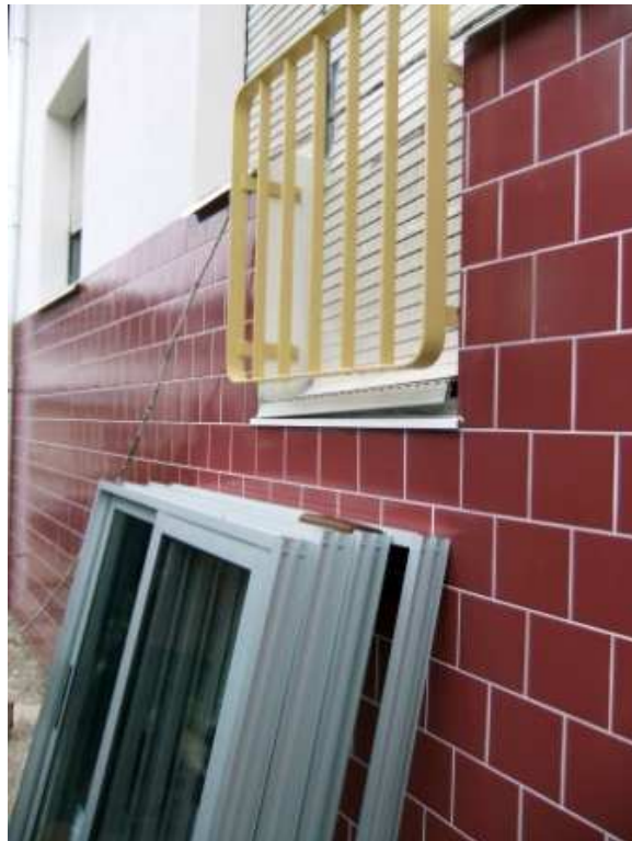
Fig. 12: a nova caixilharia exterior (com vidros duplos) e o novo embasamento em azulejo, que protege o isolamento térmico exterior e proporciona parte da imagem renovada ao edificado
