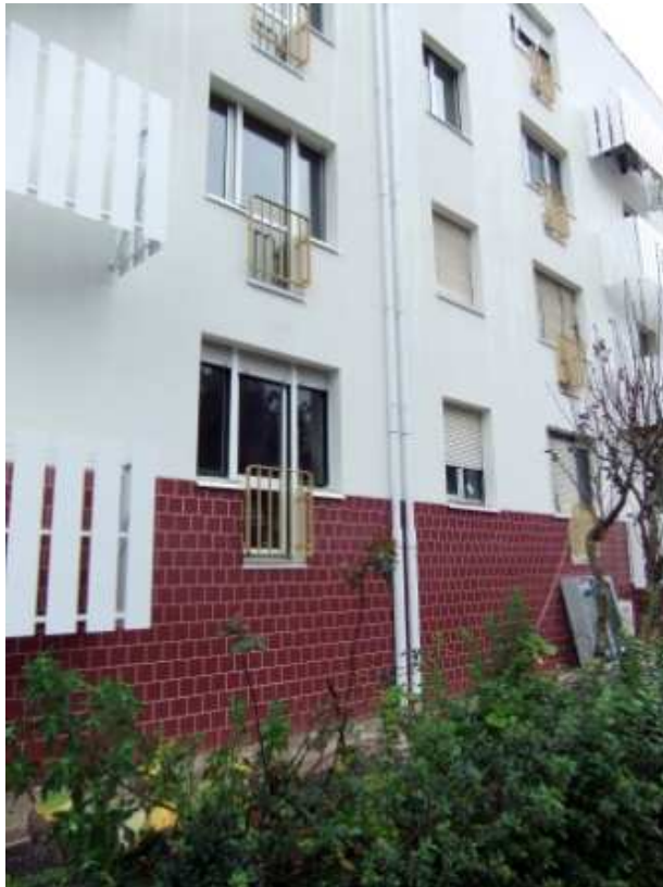
Fig. 17: a obra já concluída em alguns edifícios
