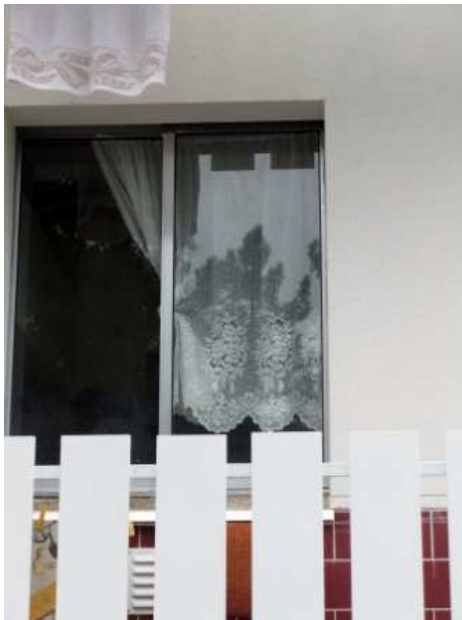
Fig. 21: Faz-se notar que os sinais de "nova vida" estão já presentes, um pouco por todo o lado, no Bairro Sá Carneiro, marcando as habitações integradas nos edifícios já reabilitados.
