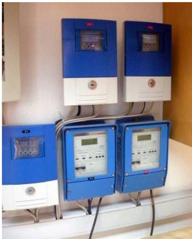
**Fig. 13** Secundários dos caudalímetros instalados na Sala de Supervisão
