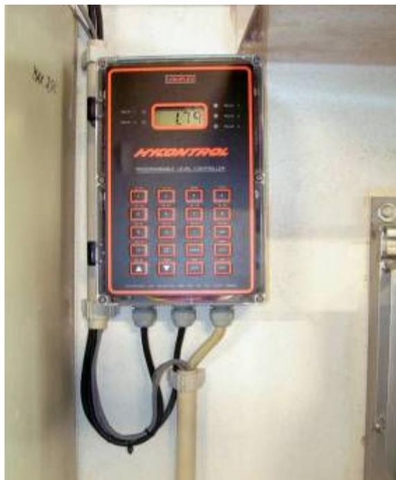
**Fig. 11** Sensor de nível do reservatório de alimentação instalado na sala de bombas.
