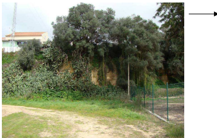
Figura 49 – Aspecto da possível falha em Melides
