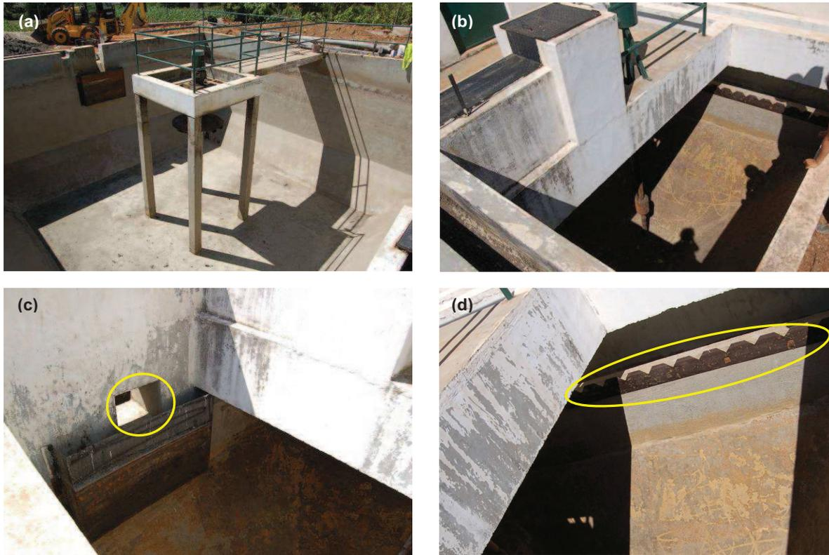
Figura 17 – Vistas da ETAR: (a) tanque de arejamento, (b) decantador secundário, (c) descarregador do tanque, (d) descarregadores do decantador
