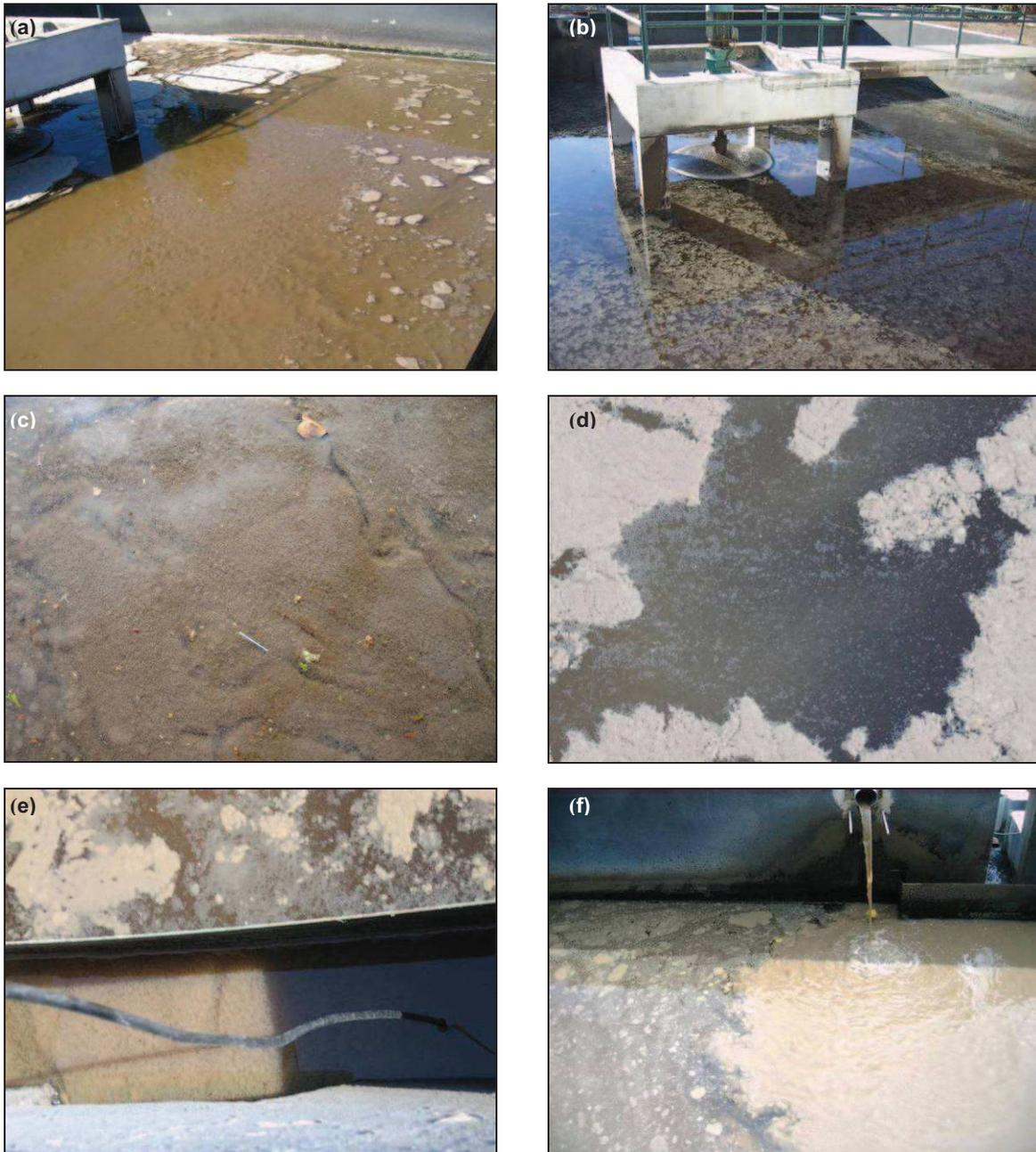
Figura 78 – Tanque de arejamento: (a) e (b) aspecto geral, (c) biomassa floculada, (d) flocos de pequena dimensão, (e) descarga de licor misto, (f) entrada de lamas recirculadas
