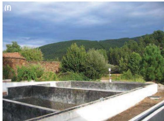
Figura 6 – Vistas da ETAR de Verdelhos: (a) geral, (b) obra de entrada, (c) tanque de arejamento, (d) decantador secundário, (e) canal de saída, (f) leitos de secagem
