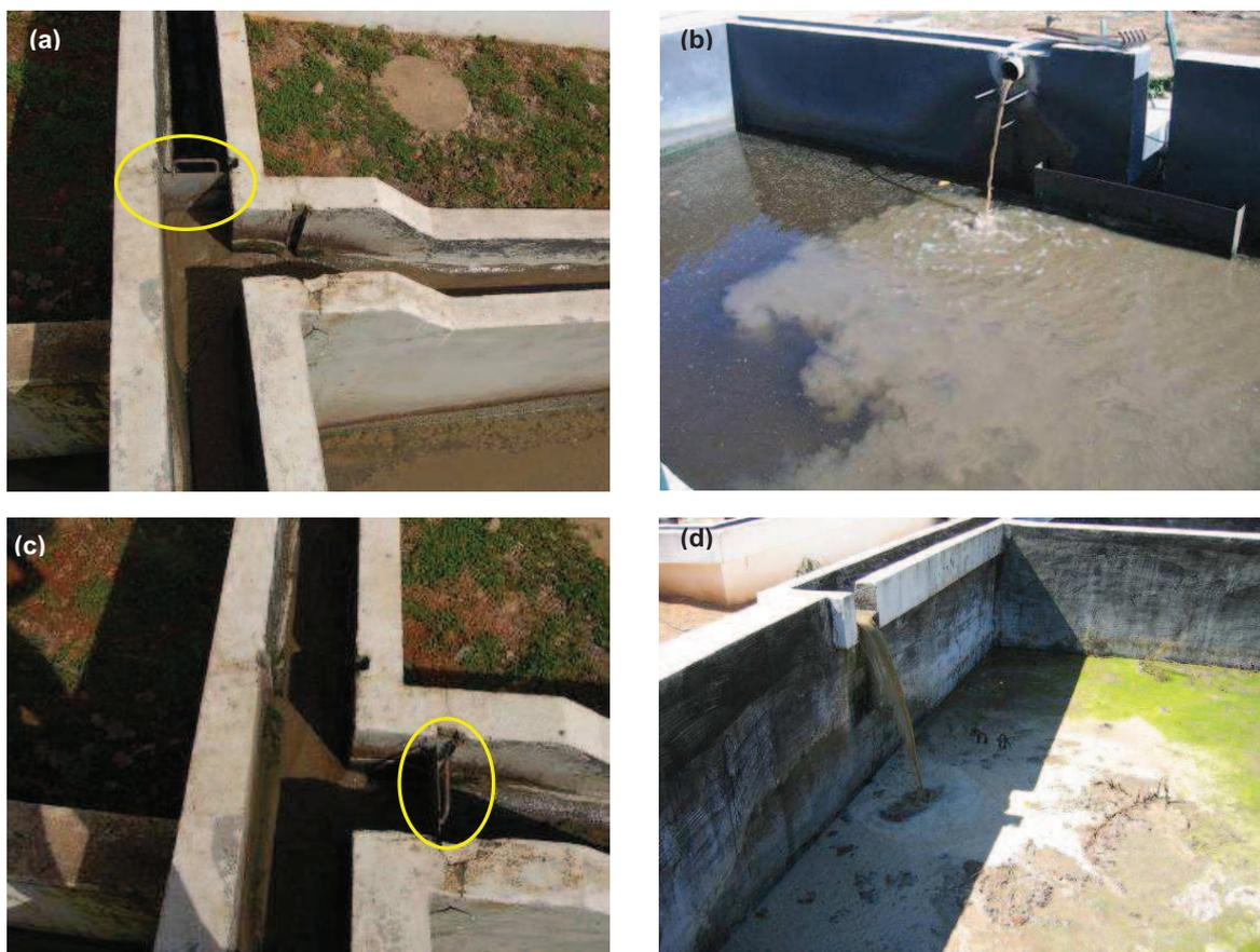
Figura 16 – Circuito de lamas: (a) e (b) recirculação para o tanque de arejamento, (c) e (d) extracção para os leitos de secagem
