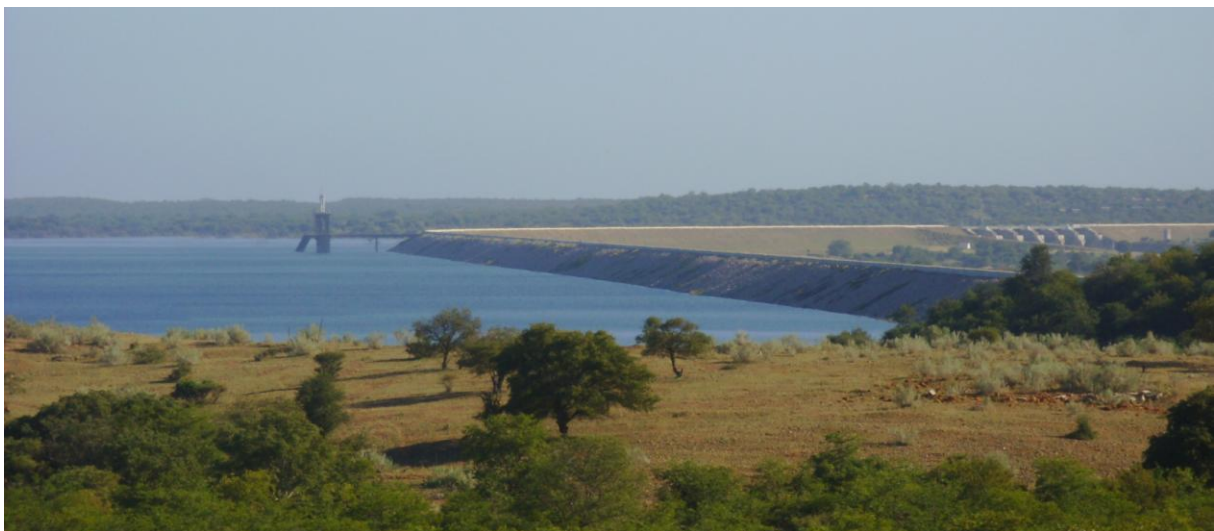
Fig 2. Vista de montante da barragem de Massingir
