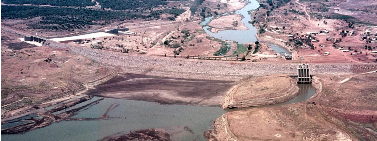
Fig 4. Vista aérea da barragem de Massingir e do tapete impermeabilizante no final da fase construtiva (Arquivo pessoal de Álvaro Carmo Vaz)
