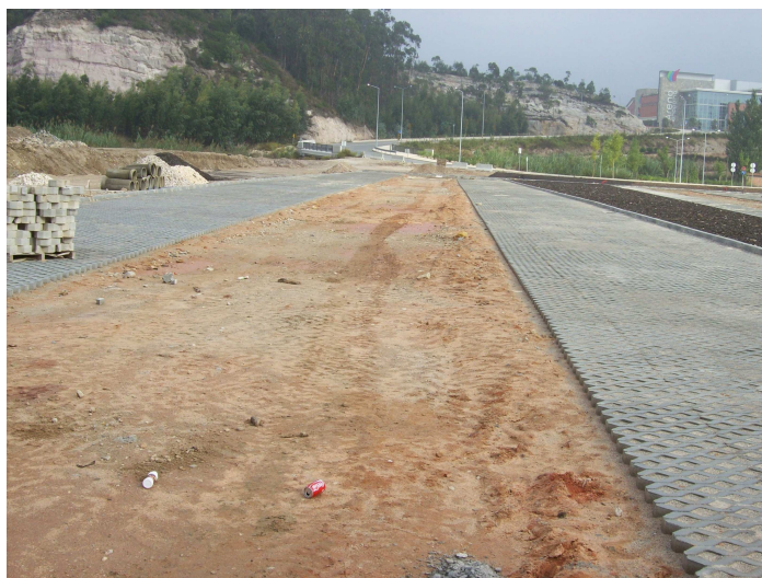
Figura 5 | Aspecto do pavimento com aplicação de RCD - Torres Vedras
