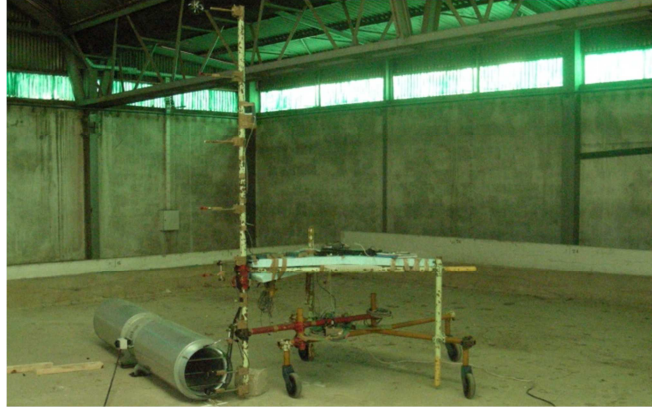
Figura 3: Pormenor da montagem da instrumentação utilizada em ensaio
