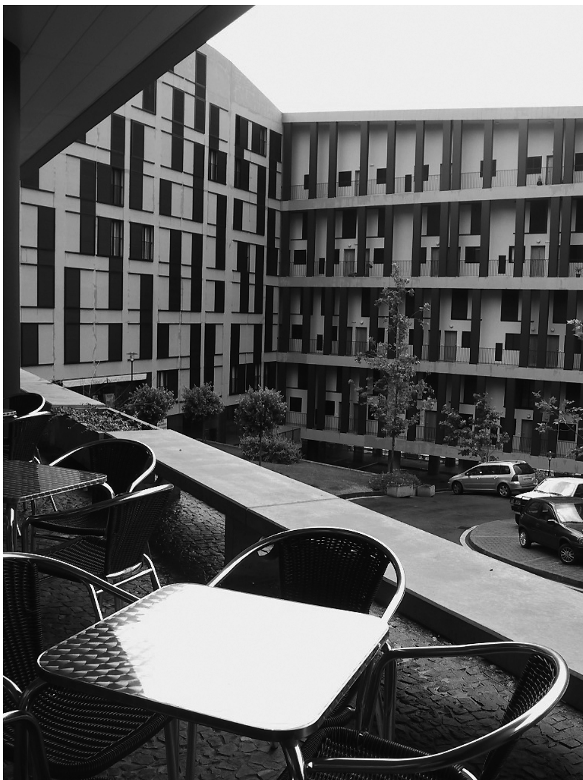
Figura 12: Vizinhança Alargada do grande conjunto de 271 fogos em cuja continuidade edificada se integra um amplo leque de equipamentos, no Amparo, Funchal, um CDH Imopro com apoio dos Investimentos Habitacionais da Madeira (IHM), arquitectos Carla Baptista e Freddy Ferreira César, 2006.
