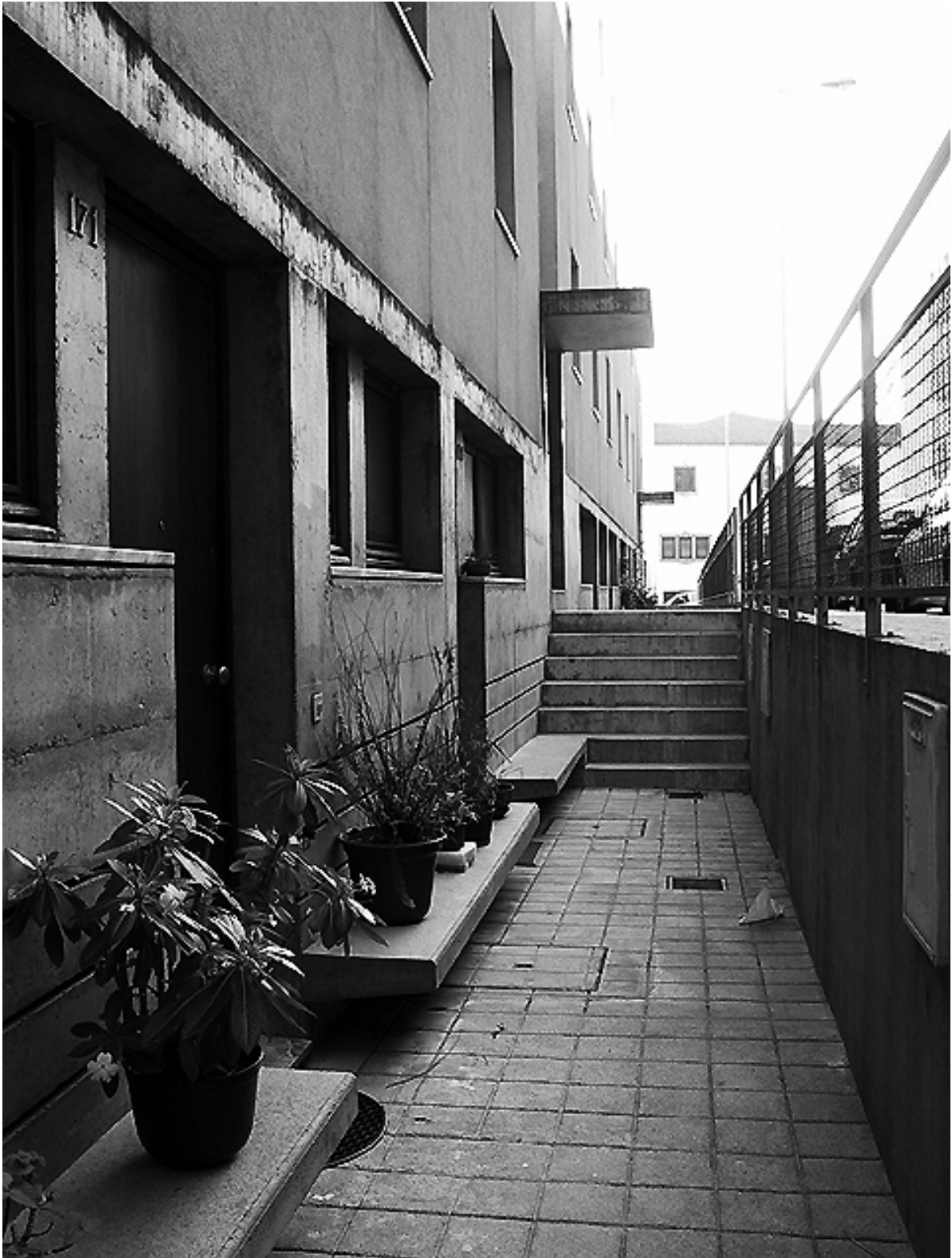
Figura 2: Pormenor da Cooperativa da Habitação Massarelos, Porto, 95 fogos, arquitectos Francisco Barata e Manuel Fernandes Sá, 1995.
