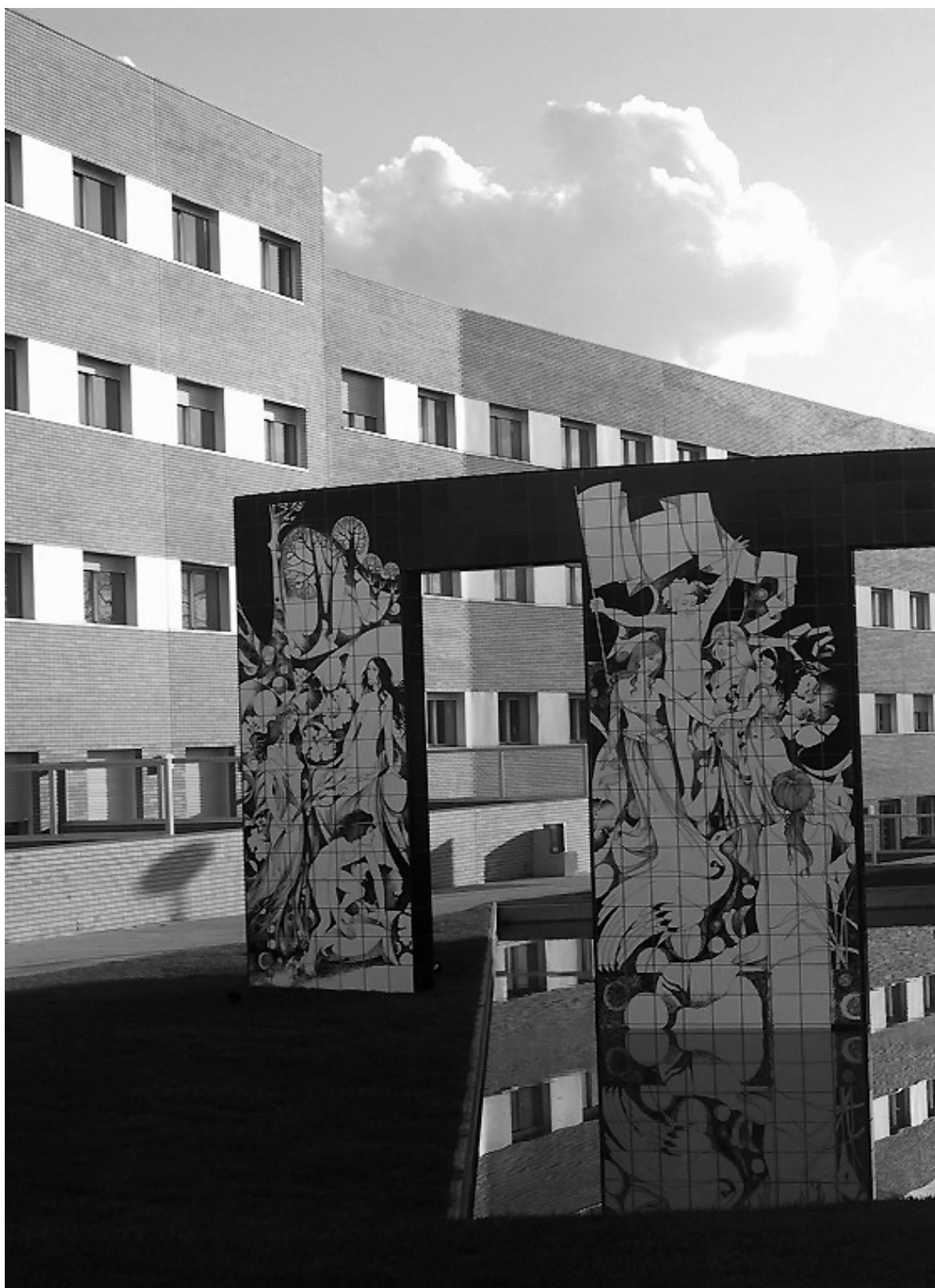
Figura 21: Pormenor do conjunto de 101 fogos na Ponte da Pedra, Matosinhos, promoção da União de Cooperativas NORBICETA, que foi Prémio SHE – Sustainable Housing in Europe, arquitecto António Carlos Coelho, 2006.
