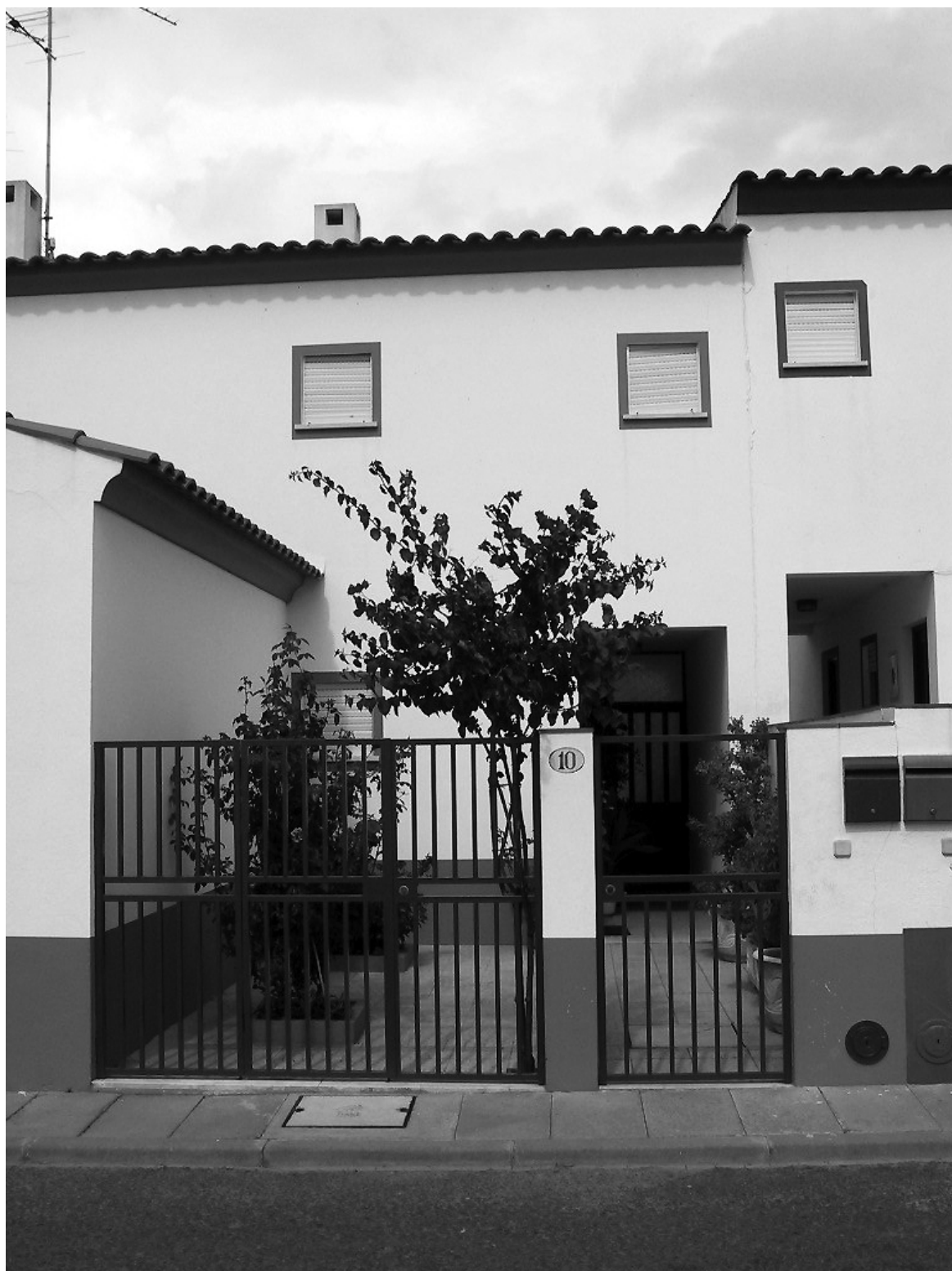
Figura 16: Pormenor de um edifício unifamiliar evolutivo do conjunto de 224 fogos da Cooperativa COOPHECAVE em Castro Verde, arquitectos Nuno Portas, Manuela Fazenda e Isabel Plácido, 1991.
