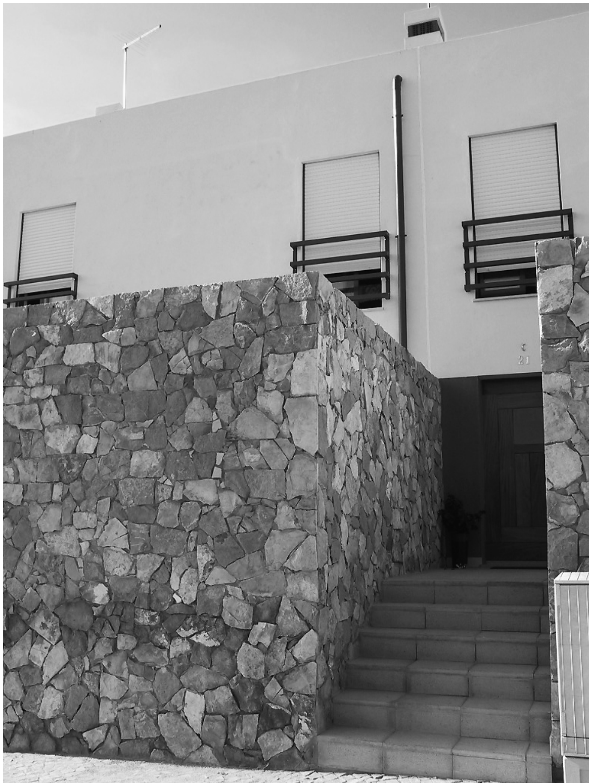
Figura 17: Pormenor do pequeno conjunto de seis fogos para realojamento de famílias de etnia cigana em Salir, uma promoção da Câmara Municipal de Loulé, arquitecto Marcelo Santos, 2005.
