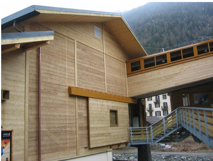
Figura 1 – Exemplo de aplicação de madeira de espruce modificado termicamente (foto: LN)
