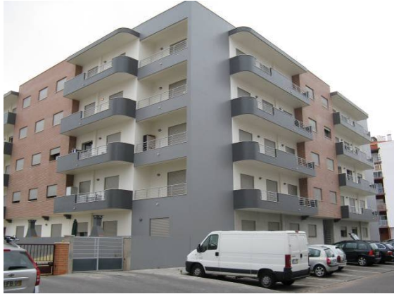
Edifício 5 ( Hab. 16 e Hab. 17 )
