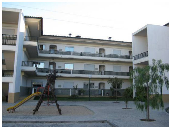
Edifício 12 ( Hab. 26 e Hab. 27 )
