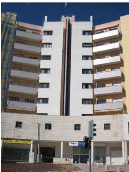
Edifício 1 ( Hab. 1 a Hab. 4 )
