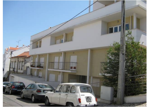
Edifício 6 ( Hab. 18 a Hab. 20 )
