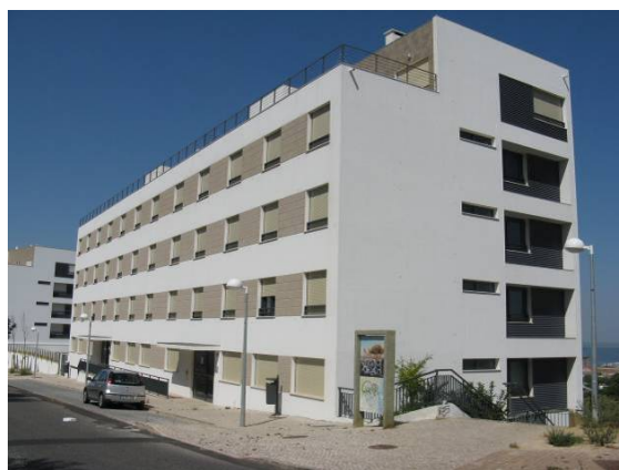
Edifício 2 ( Hab. 5 a Hab. 13 )
