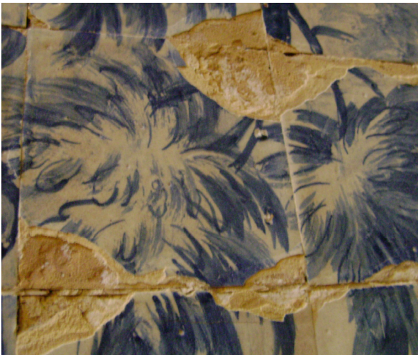
Figuras 10, 11- Danos de cristalização no corpo dos azulejos, sendo visíveis eflorações
