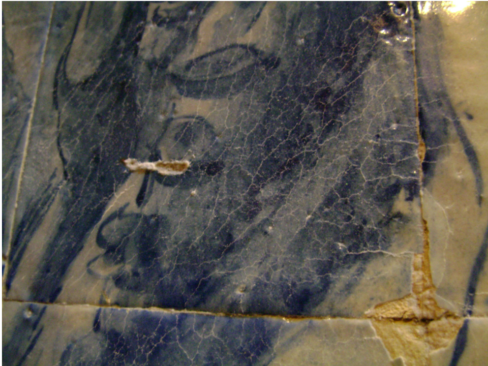
Figura 12- Craquelé delineado com eflorescências. Nota-se, também, cristalização no poro.
