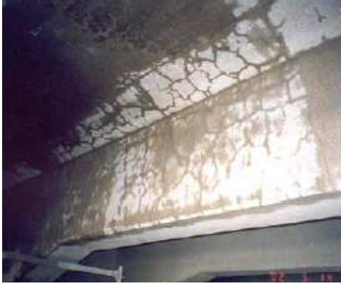
Figura 3 – Aspecto visual da fendilhação em viga de um tabuleiro de uma ponte.
