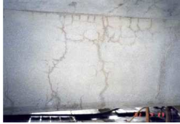
Figura 3 – Aspecto visual da fendilhação em viga de um tabuleiro de uma ponte.
