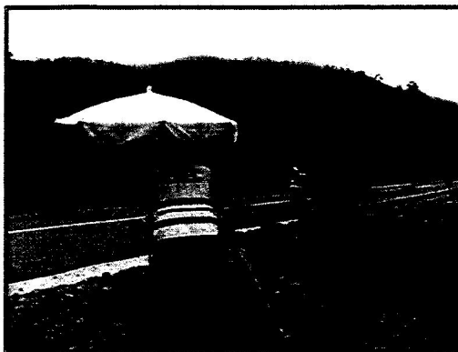
Figura 4 – Nivelamento de P2.
