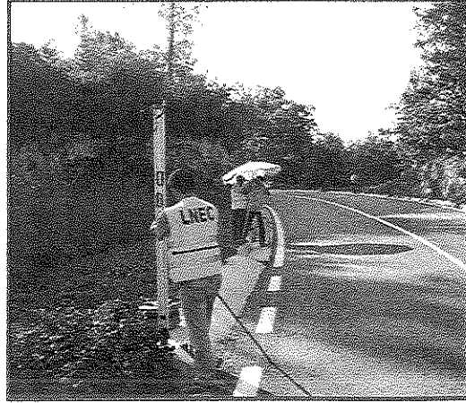
Figura 4 – Nivelamento do ponto P2.
