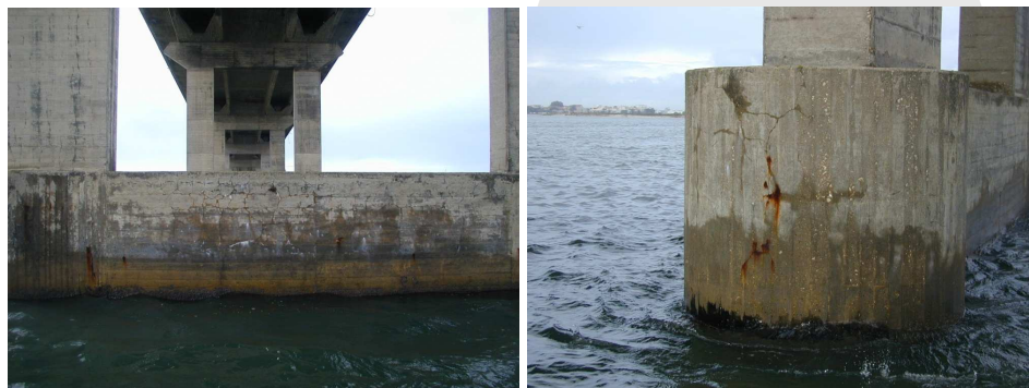
Ponte da Barra (2006)
