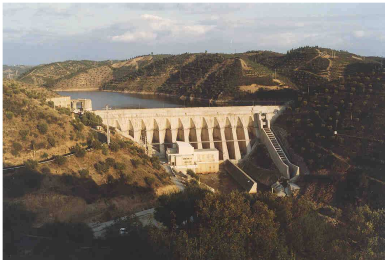
Barragem de Pracana
