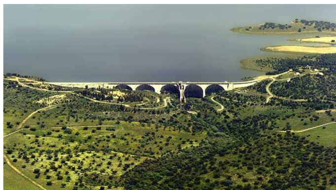
Fig. 3: Barragem de Odivelas
