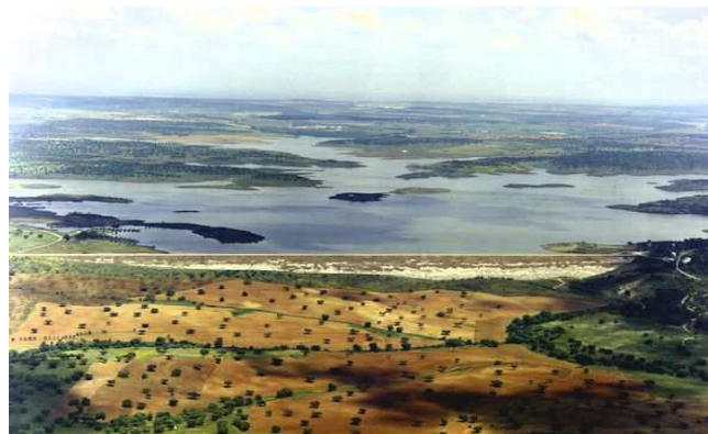
Fig. 4: Barragem de Alvito
