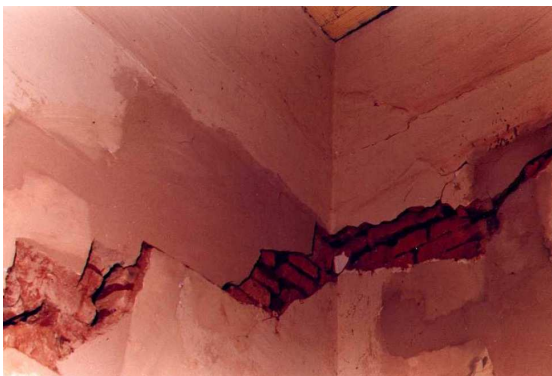
Figura 1. Danos em edificações, devidos a assentamentos por colapso, por subida do nível freático (Cidade Pereira Barreto, SP, Brasil). Fotografias retiradas de Rodrigues, R. A. (2007).
