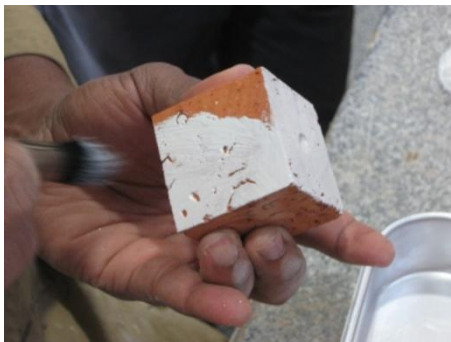
Figura 3.2.9 – Pormenor de aplicação da impermeabilização no provete
