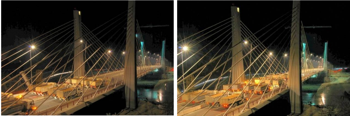
Figura 7. Comboio de carga no decurso dos ensaios estáticos.
