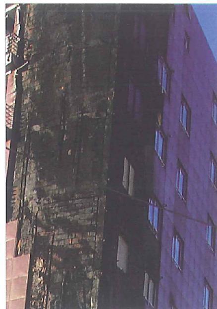
Fig. 2 Resultado do incêndio numa fachada ventilada de um edifício em uso.
