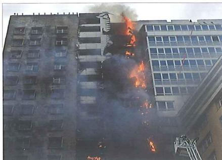
Fig. 3 Aspectos da evolução do desenvolvimento de um incêndio numa fachada ventilada de um edifício em Moscovo.
