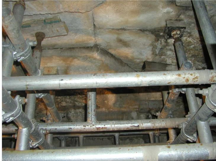
Figura 4 – Aspecto do deslizamento de alguns blocos de pedra
