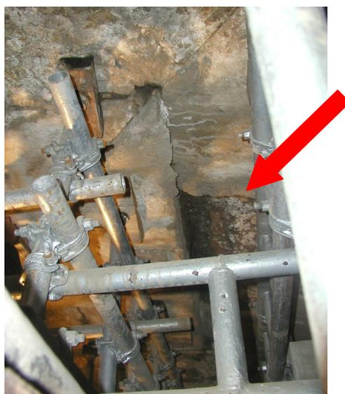
Figura 3 – Localização na abóbada do bloco de pedra em falta
