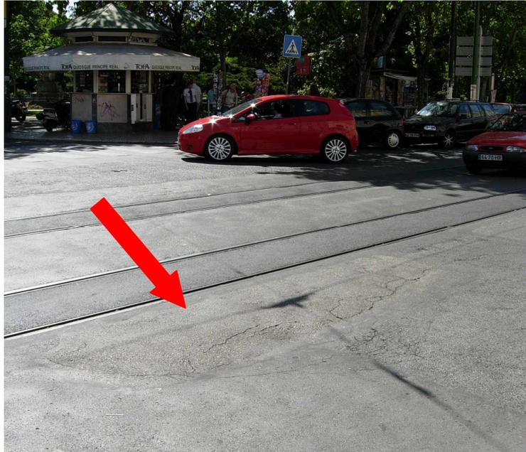
Figura 6 – Cedência da faixa de rodagem, sobre a abóbada de alvenaria
