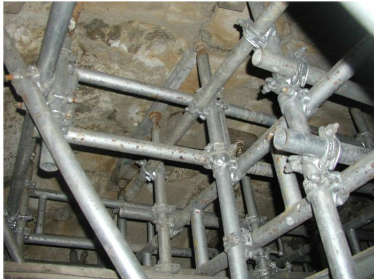
Figura 5 – Vista parcial da estrutura provisória de suporte da abóbada de alvenaria
