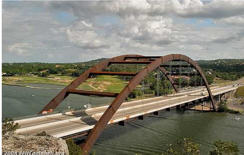
Figura 7 Ponte em aço patinável [5]
