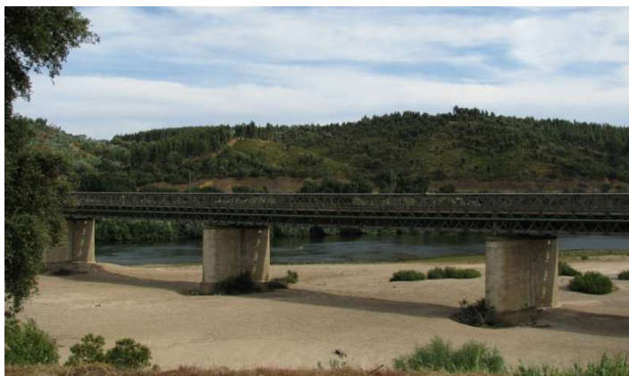
Figura 28 Ponte da Praia do Ribatejo
