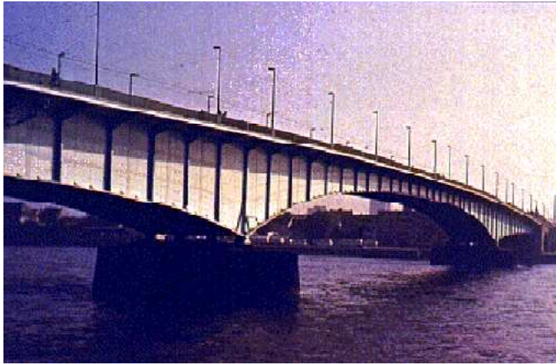
Figura 25 Ponte sobre o rio Reno [1]
