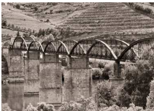
Figura 29 Ponte da Régua
