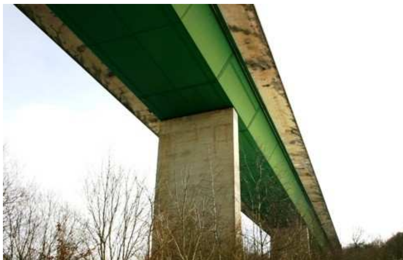
Figura 27 Solução estrutural - ponte mista
