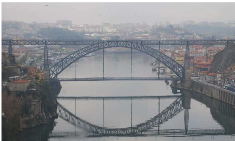
Figura 32 Ponte Luís I
