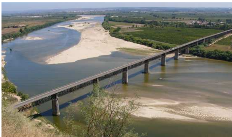
Figura 33 Ponte D. Luís
