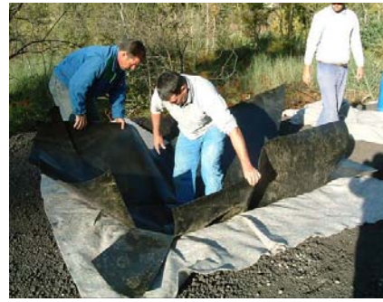
(b) - Instalação da geomembrana
