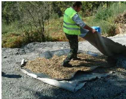
(c) - Vala preenchida com seixo rolado
