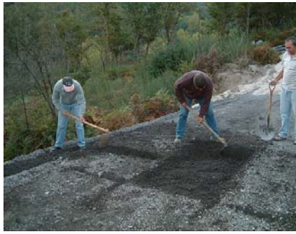
(a) - Abertura da vala
