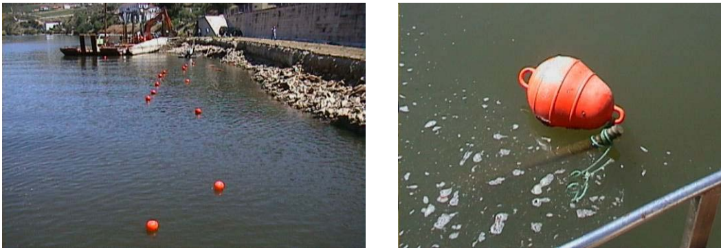
Figura 4 – Levantamento Subaquático dos Varões das Ancoragens Encontradas Pelos Mergulhadores
