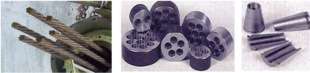
Figura 7 – Acessórios para Cabeça de Ancoragens de Cordões: a) Cordões; b) Bases; c) Clavetes (Carvalho, 2009)
