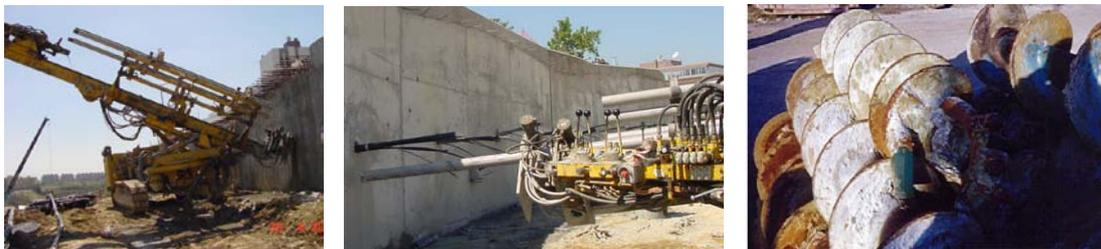
Figura 7 – Equipamento para Furos por Rotação com Circulação de Água e Hastes Rotativas Helicoidais
