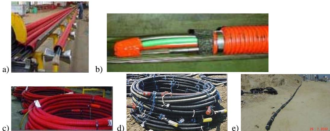
Figura 5 – Exemplo de Ancoragens com Armadura de Cordões: a) Assemblagem em Fábrica; b) Pormenor de um Tipo de Extremidade Posterior; c) Acondicionamento; d) Colocação em obra; e) Desenrolamento para introdução no furo
