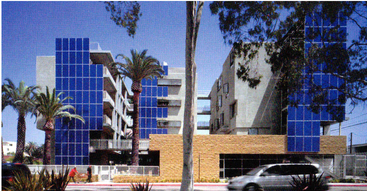
Figura 40 – Fachada de habitação com painéis fotovoltaicos.
