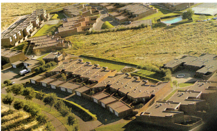
Figura 20 – Bairro-piloto de “La Luz” construído em terra.
