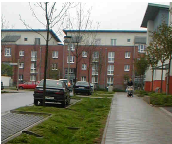
Figura 16 – “Caleiras verdes” para infiltração da água no solo.
