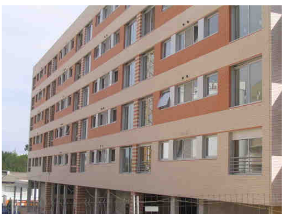
Figura 131 – Conjunto habitacional de Ponte da Pedra.
