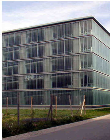
Figura 126 – Silos automóveis. Bairro Vauban (Freiburg). As garagens automáticas, em que os carros são elevados em plataformas, consomem menos iluminação e menos espaço. No entanto, como o investimento inicial era maior e por haver alguns precedentes de problemas de manutenção, a câmara de Freiburg optou por silos convencionais com acessos por rampas.
