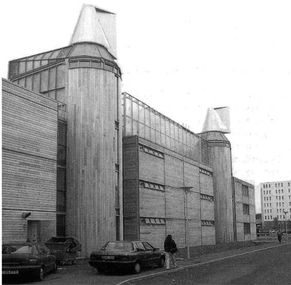
Figura 59 – Torres de ventilação com terminais rotativos. Jubilee Campus, Nottingham. (fonte: Architecture in a climate of change)
