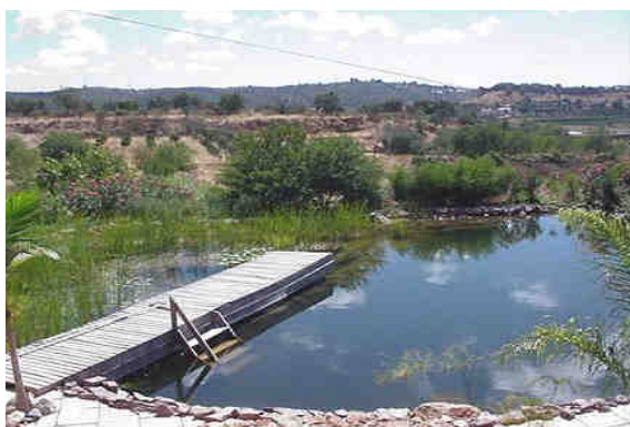
Figura 31 – Piscina biológica para tratamento de águas pluviais.
