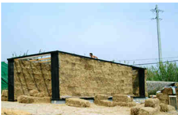
Figura 89 – Construção em fardos de palha, antes de rebocada.
