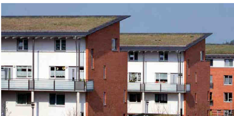
Figura 14 – Regulação da humidade através de coberturas verdes.
