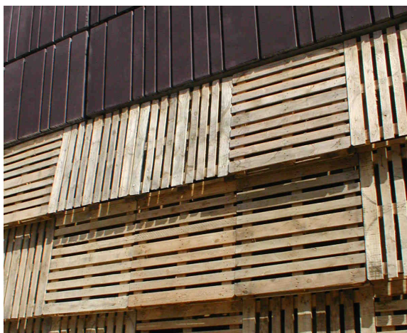
Figura 36 – Reutilização de paletes em fachada de edifício.
