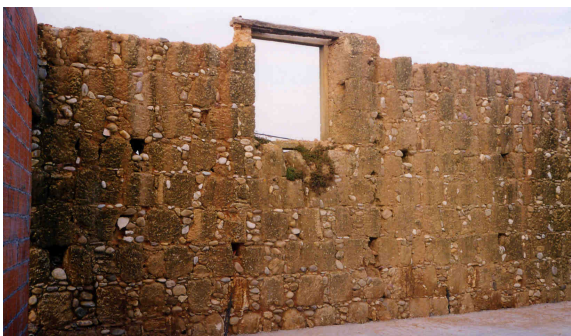
Figura 93 – Construção em pedra de tufo, seixos e terra. Casal do Vale, Torres Novas.
