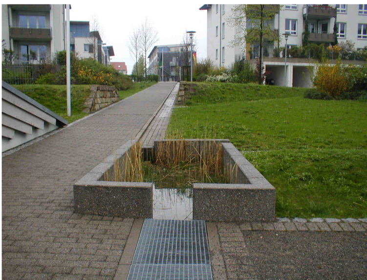
Figura 15 – Regulação da temperatura e tratamento biológico de águas pluviais em espaços públicos.
