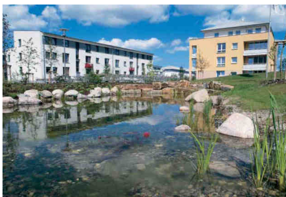
Figura 32 – Bio-lagunagem para tratamento de águas pluviais.
