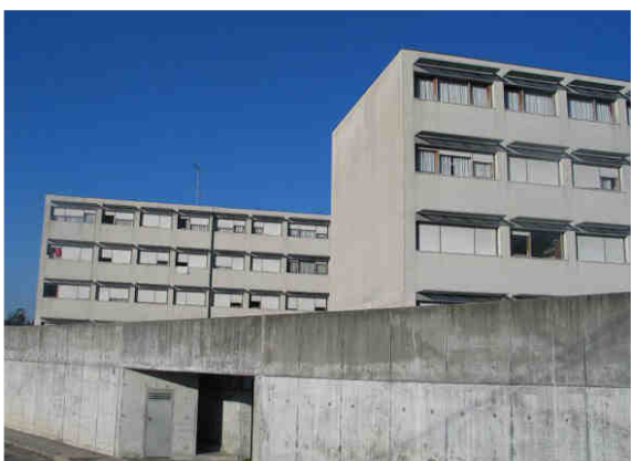
Figura 130 – Conjunto habitacional em Gondifelos. Arq. os José Gigante e João Álvaro Rocha, Vila Nova de Famalicão, 1997.
