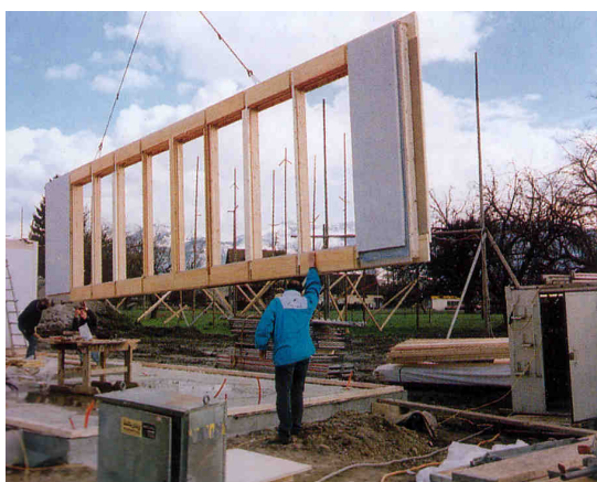
Figura 98 – Fachada de madeira pré-fabricada.
