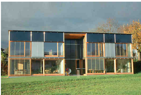
Figura 50 – Colectores térmicos em habitação geminada.
