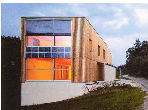
Figura 70 – Utilização de PV integrado em fachada de edifício de habitação unifamiliar.
