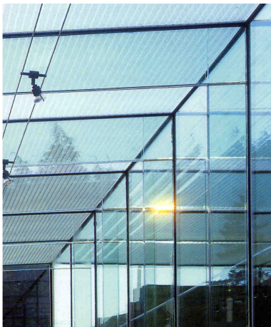
Figura 97 – Vidro estrutural no Museu do vidro em Kingswinford.
