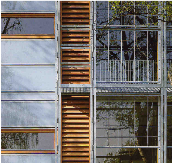
Figura 45 – Isolante translúcido com aerogel integrado em fachada polivalente, à esquerda.
