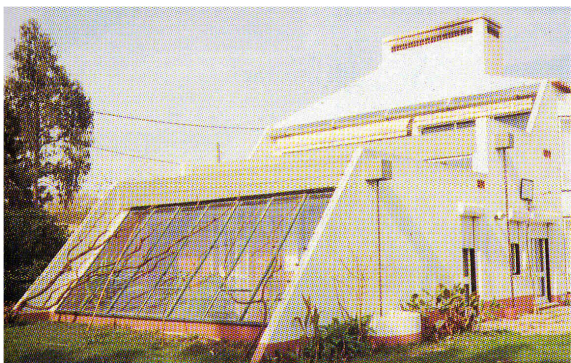
Figura 56 – Aspecto de estufa no Inverno. Arq.º Fausto Simões, Casa Vale do Rosal. (fonte: Edifícios solares passivos em Portugal)
