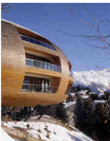
Figura 106 – Conjunto habitacional Chesa Futura. Arq.º Norman Foster, 2002.
