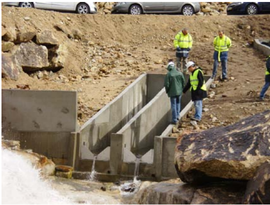
Figura 12- Medidores de Caudais, Leituras de Caudais e Comparação com o NAA
