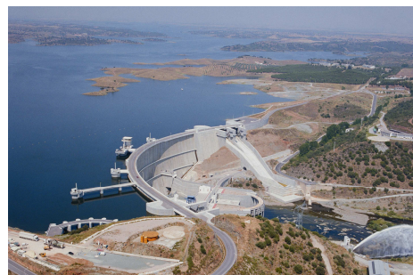
Fig. 3 – Vista geral da barragem de Alqueva
