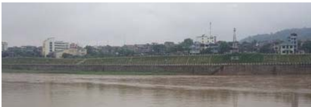
Figura 2 – Dique de protecção na cidade de Hanoi
